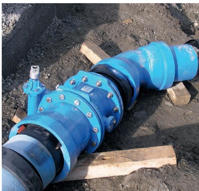
Dank der flexiblen Steckmuffen-Verbindung können Rohre, Formstücke und Armaturen einfach und schnell montiert und wieder demontiert werden.
