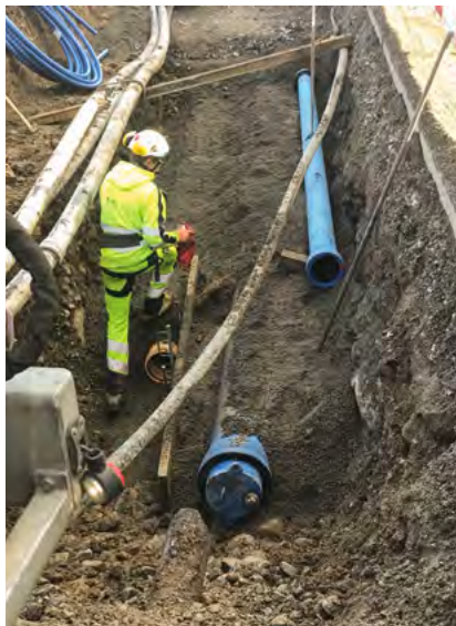
Die beiden parallel verlegten Leitungen: rechts DN 150, links DN 250 mit sicher abdichtendem P-Stopfen.
